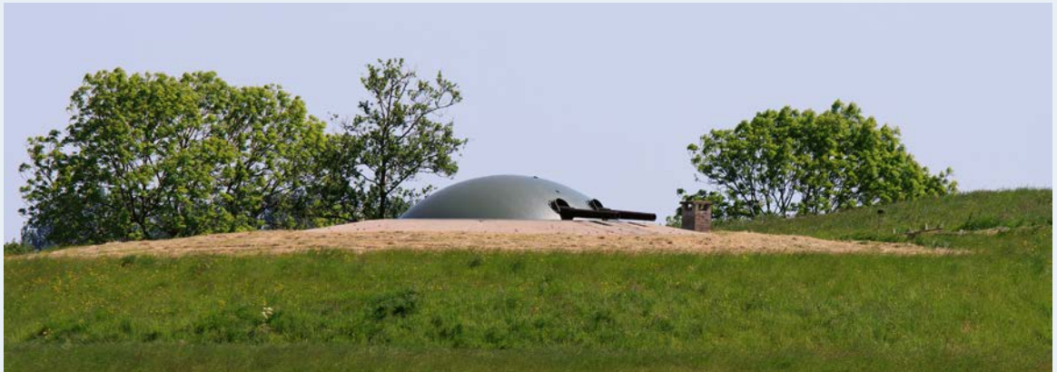
Stalen geschutskoepel uit 1911 bij Fort Spijkerboor, onderdeel van de Stelling van Amsterdam. Foto: RCE.
