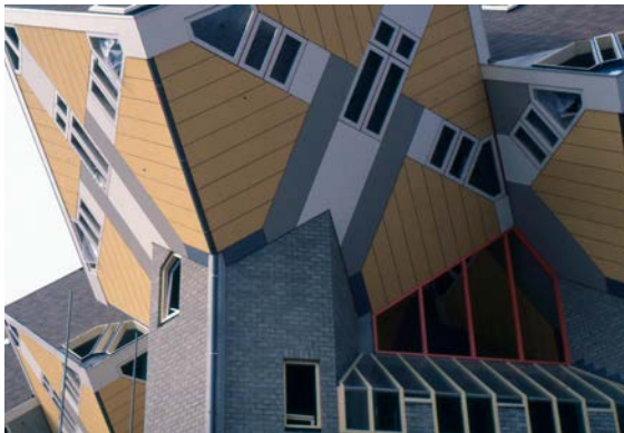
Paalwoningen, Piet Blom, Rotterdam. Foto Noud de Vreeze
