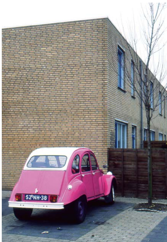
De economische crisis van 1979 leidde tot versobering in de woningbouw. Foto Noud de Vreeze
