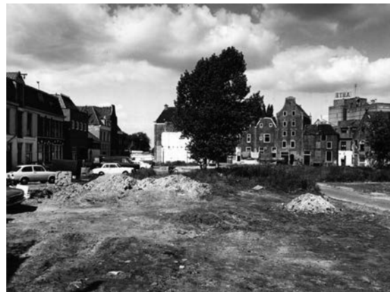
Kaalslag in de binnenstad van Zwolle begin jaren zeventig. Foto RCE-beeldbank
